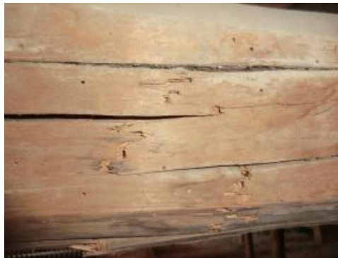
Figura 7. Fendas en madera. Fuente: https://sanite.es/
