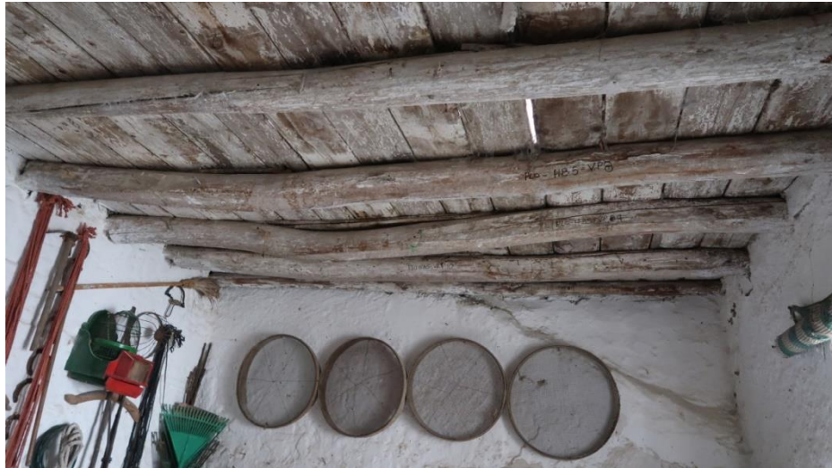
Figura 29. Vista del forjado PL0-HB5.
