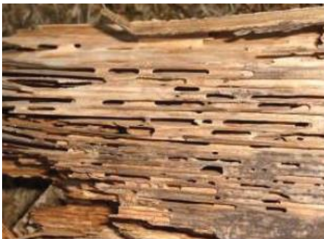
Figura 14. Madera estructural afectada por termitas. Fuente: (Azcona, 2018)
