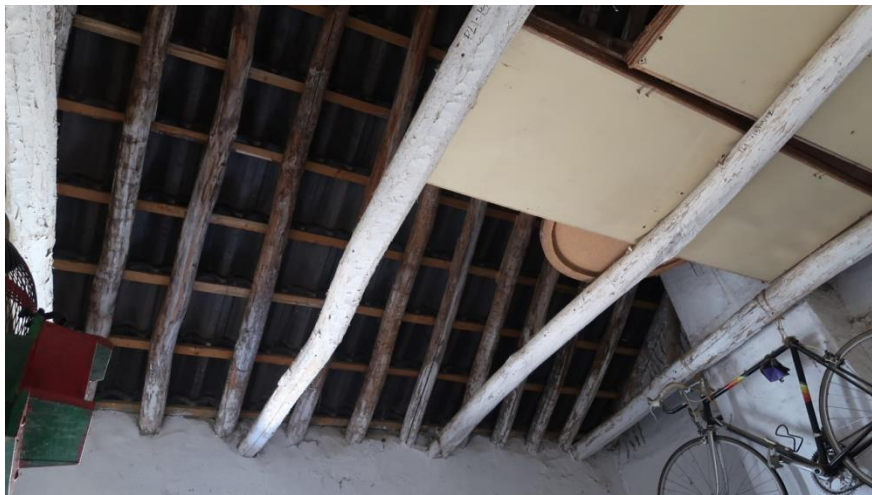
Figura 31. Vista del forjado PL1-HB1.
