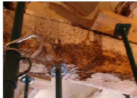
Figura 14. Madera estructural afectada por termitas. Fuente: (Azcona, 2018)
