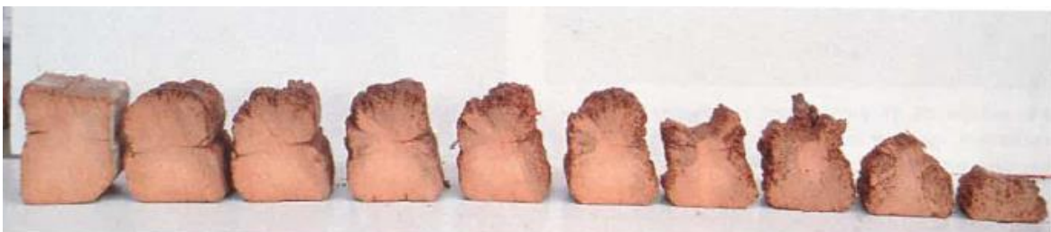
Figura 12. Pudrición parda en vigas de madera. Fuente: (AITIM, 1992)
