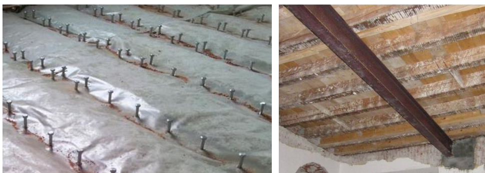
Figura 2.2.1: Estructura de madera reforzada con hormigón y estructura de madera reforzada con acero.
