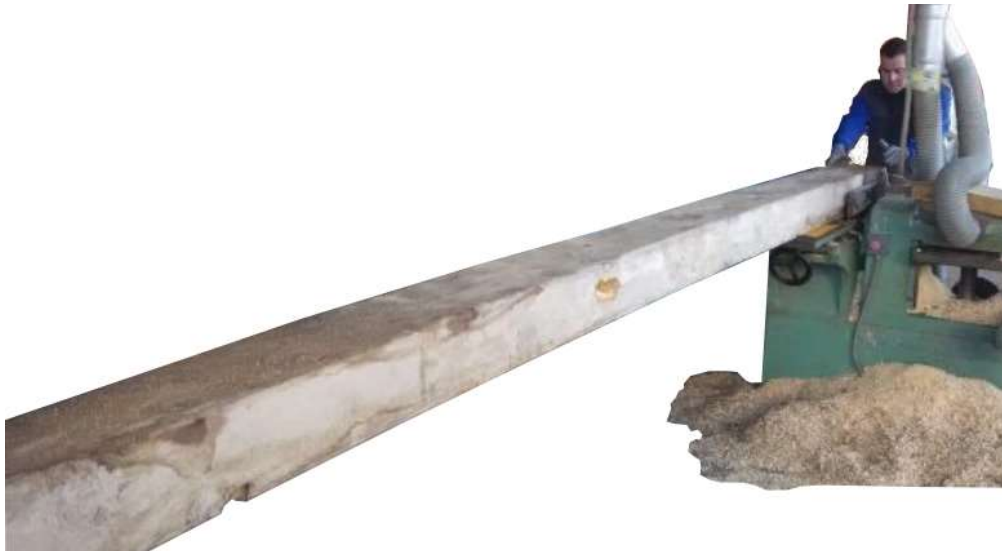
Figura 4.2 Cepillado de la viga para su regularización.
