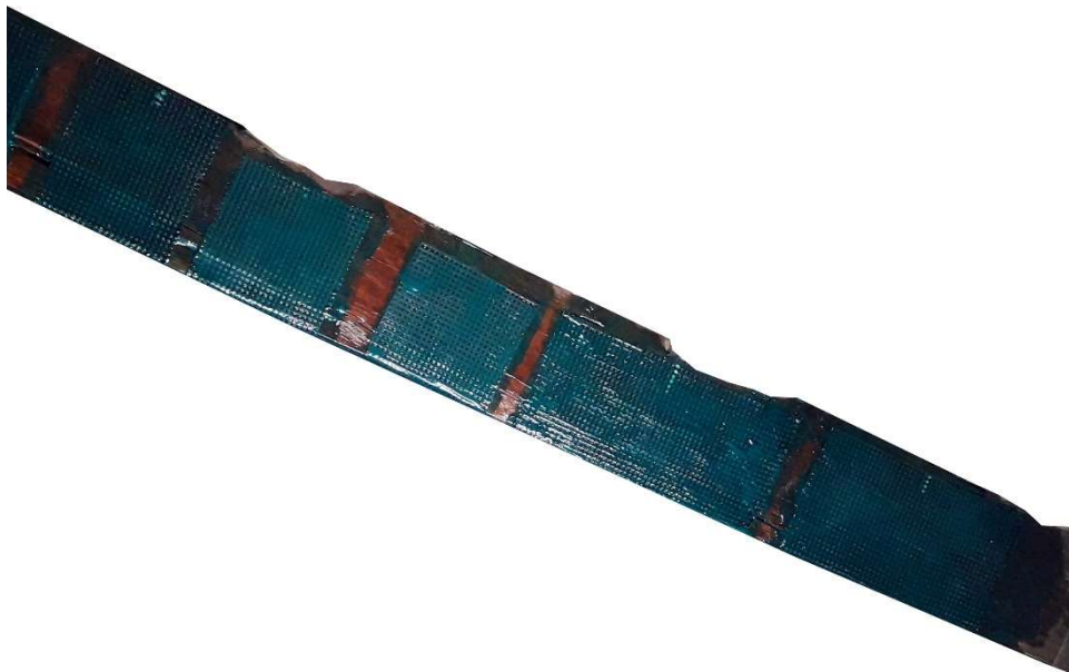
Figura 7.27 Vista lateral del tejido de CFRP una vez colocado en la viga.
