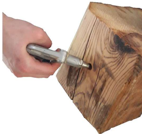
Figura 7.5 Limpieza de los agujeros de las piezas de madera con pistola de aire a presión.
