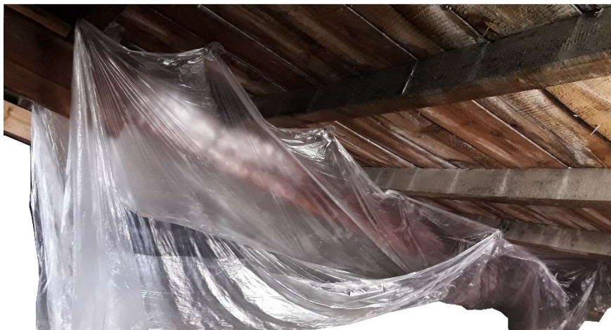
Figura 7.23 Protección de la viga frente al polvo tras la imprimación.
