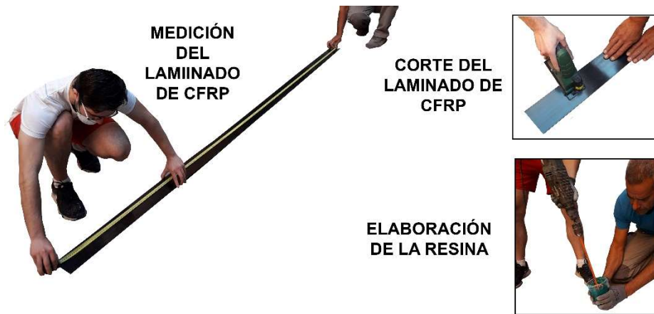
Figura 7.24 Medición y corte del laminado de CFRP.
