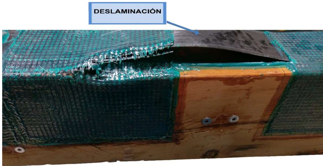
Figura 6.55 Deslaminación de la viga BR-r-2 tras su rotura.
