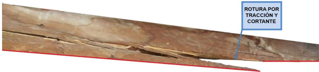
Figura 7.1 Fotografía de la rotura de la viga. Línea roja: cara traccionada.
