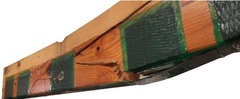
Figura 6.12 Fotografía de la rotura por tracción y cortante de la viga BR-U-2.
