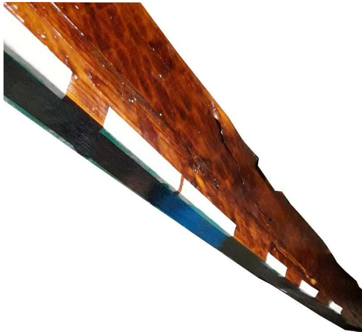
Figura 7.25 Proceso de adhesión del laminado de CFRP en la cara inferior de la viga.
