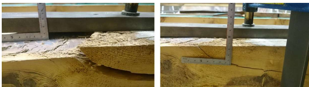
Figura 5.9 Izquierda: grieta de una viga rota. Derecha: colocación de viga rota en su posición original.
