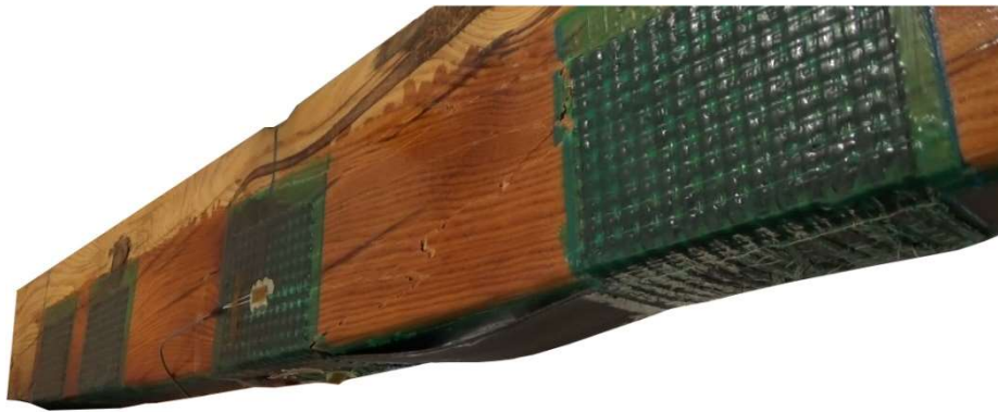
Figura 6.26 Fotografía de la rotura por tracción y cortante de la viga BR-B-2.
