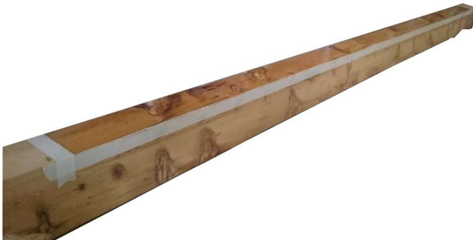
Figura 4.3 Aplicación de la imprimación sobre viga de gran cuadría.
