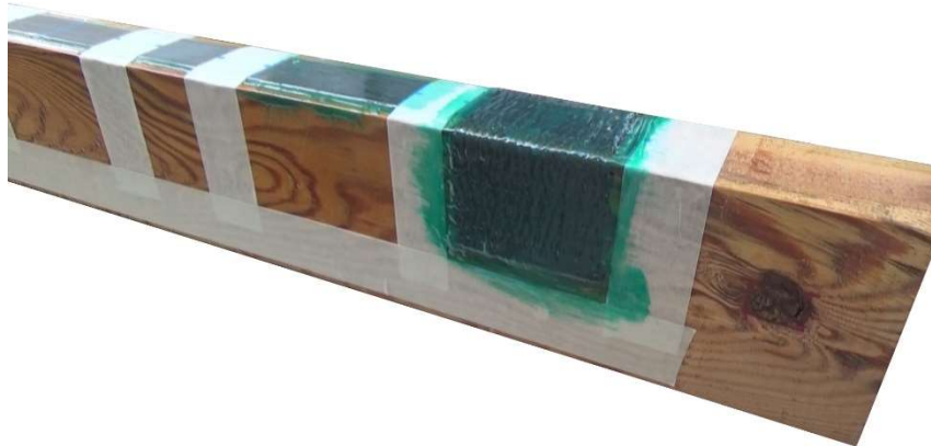
Figura 4.6 Colocación del tejido CFRP sobre una viga de pequeña escuadría.
