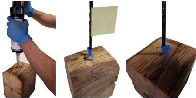
Figura 7.8 Izquierda: vertido de la resina Tipo 5 en el agujero de la pieza de madera. Centro: inserción de la varilla de fibra de vidrio en la pieza de madera. Derecha: retirada de resina sobrante.
