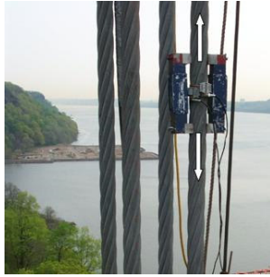
Figura 2.9: Ejemplo de inspección de cables con sensores de EA realizada por la empresa WINS-NDT.
