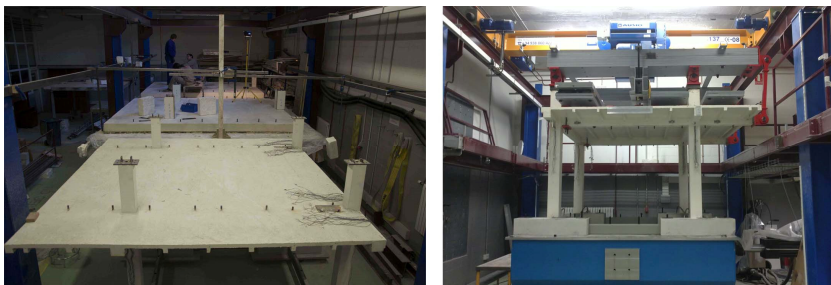
Figura 4.30: Modelo de ensayo. Izqda.: Completamente hormigonado. Dcha.: Situado sobre la mesa sísmica con las cargas y sobrecargas colocadas.
