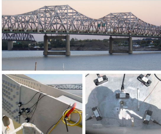
Figura 2.10: Superior: Puente en memoria de John F. Kennedy (río Ohio entre los estados de Indiana y Kentucky). Inferior: colocación de sensores de EA sobre la estructura metálica [48].
