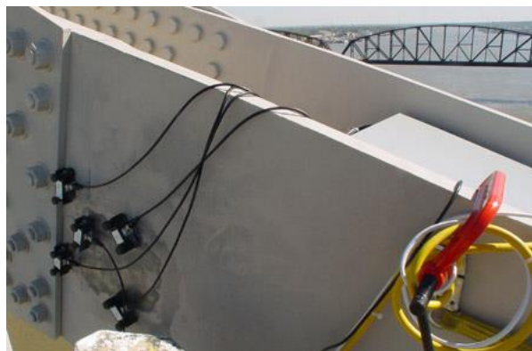
Figura 2.2. Aplicación del método de emisión acústica en la estructura de un puente.
