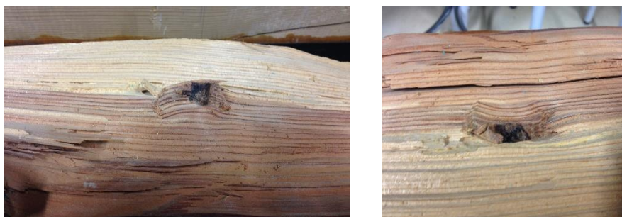
Figura 5.38. Nudo interno separado en 2 mitades. Viga LRS1.
