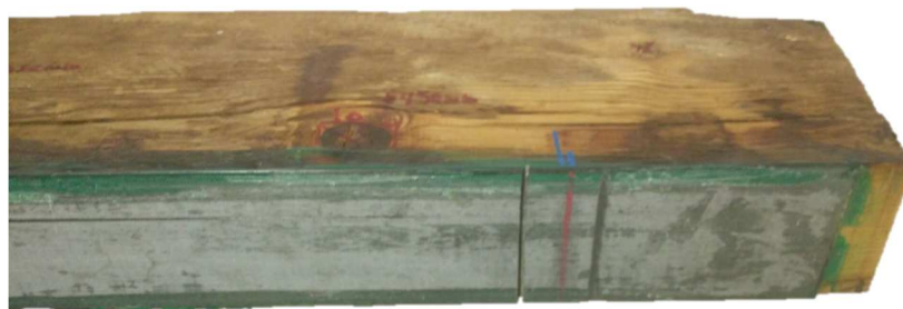
Figura 2.20. Fotografía de una viga con el refuerzo LR-D-F.
