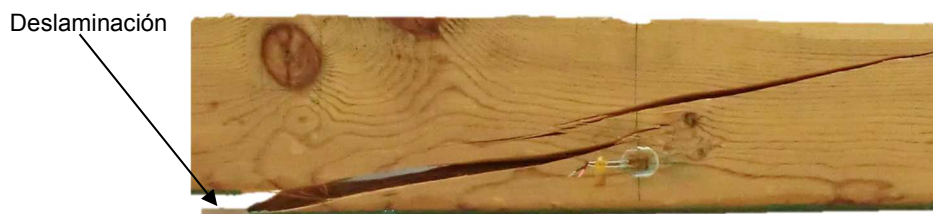
Figura 4.49. Rotura de la viga LR-D-F-2.
