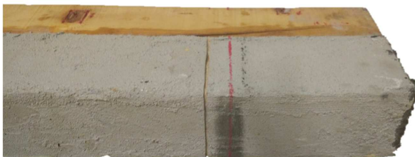
Figura 2.22. Fotografía de una viga con el refuerzo WR-S.
