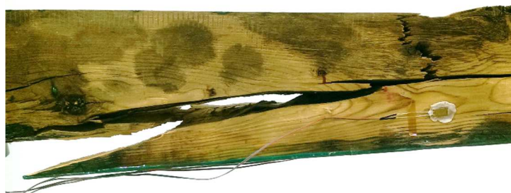
Figura 4.52. Rotura de la viga LR-D-F-3.
