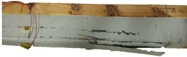
Figura 4.58. Rotura de la viga WLR-S-2.
