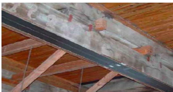
Figura 1.1. Refuerzo de puente de Sins con láminas de material compuesto de fibra de carbono [3].
