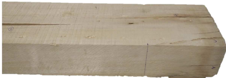
Figura 2.15. Fotografía de una viga sin reforzar.
