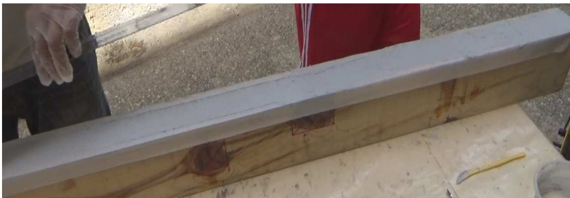
Figura 2.29. Fotografía de una viga a la cual se le ha aplicado la primera capa de resina.
