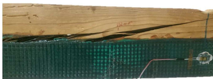
Figura 4.106. Rotura de la viga WR-D-B-3.
