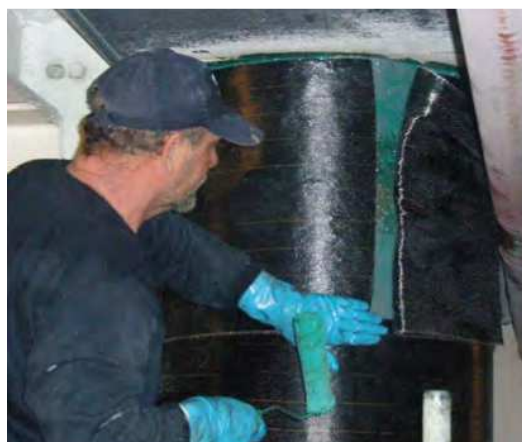
Figura 2.13. Ejecución de un refuerzo de forjado mediante CFRP en forma de tejido, en un elemento cilíndrico [24].
