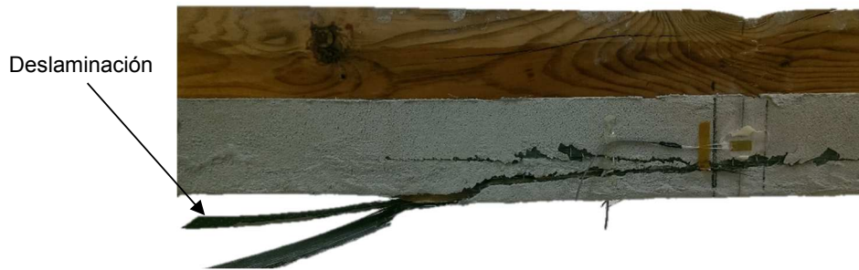
Figura 4.82. Rotura de la viga WR-S-1.
