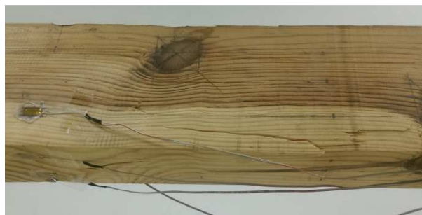
Figura 4.11. Rotura de la viga NR-3.
